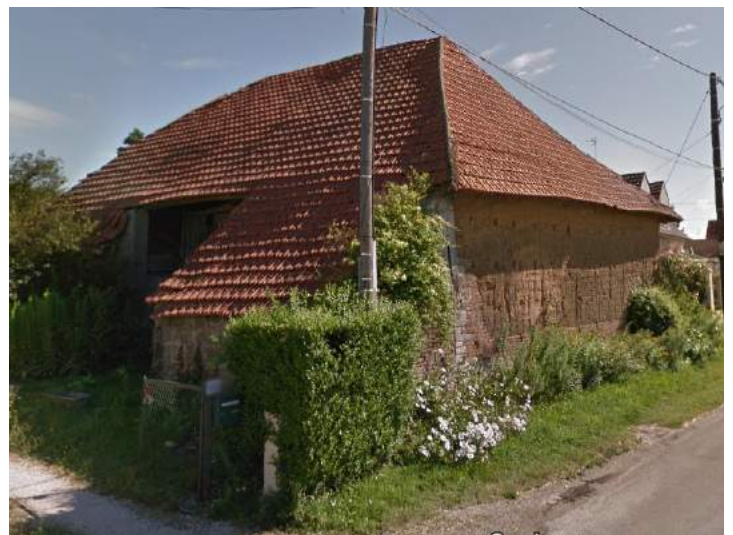
Le détail des murs du pisé de la grange de Chaughey et la grange d'Esbarres
